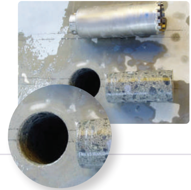
2- Extraemos el punzón cuando la corona haya penetrado levemente.
